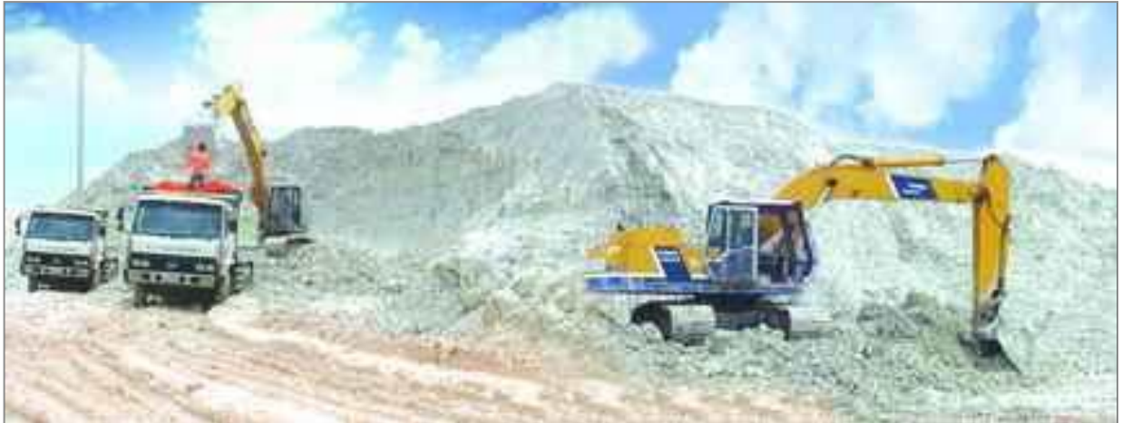
Công trường khai thác cao lanh
