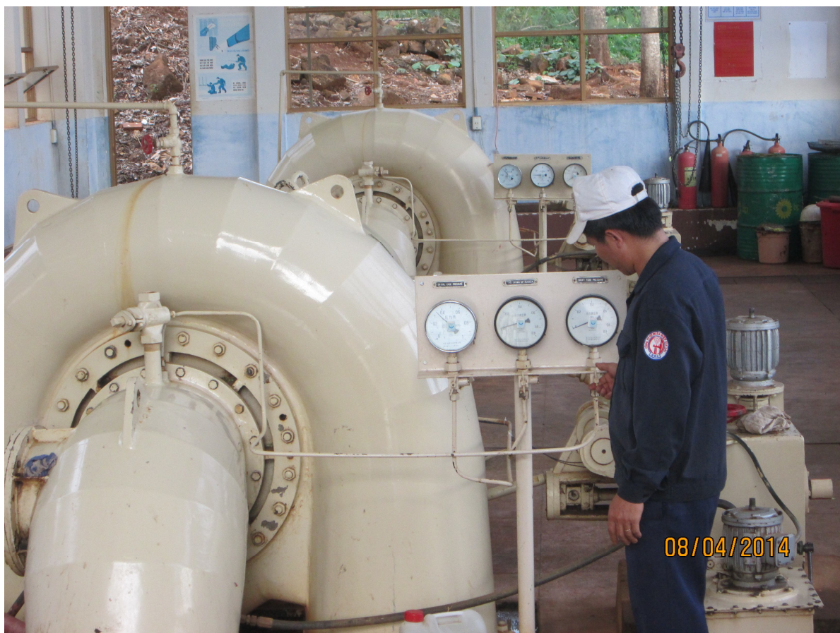
Ảnh: Kiểm tra các thông số máy phát tại nhà máy thủy điện Ia Đrăng1
