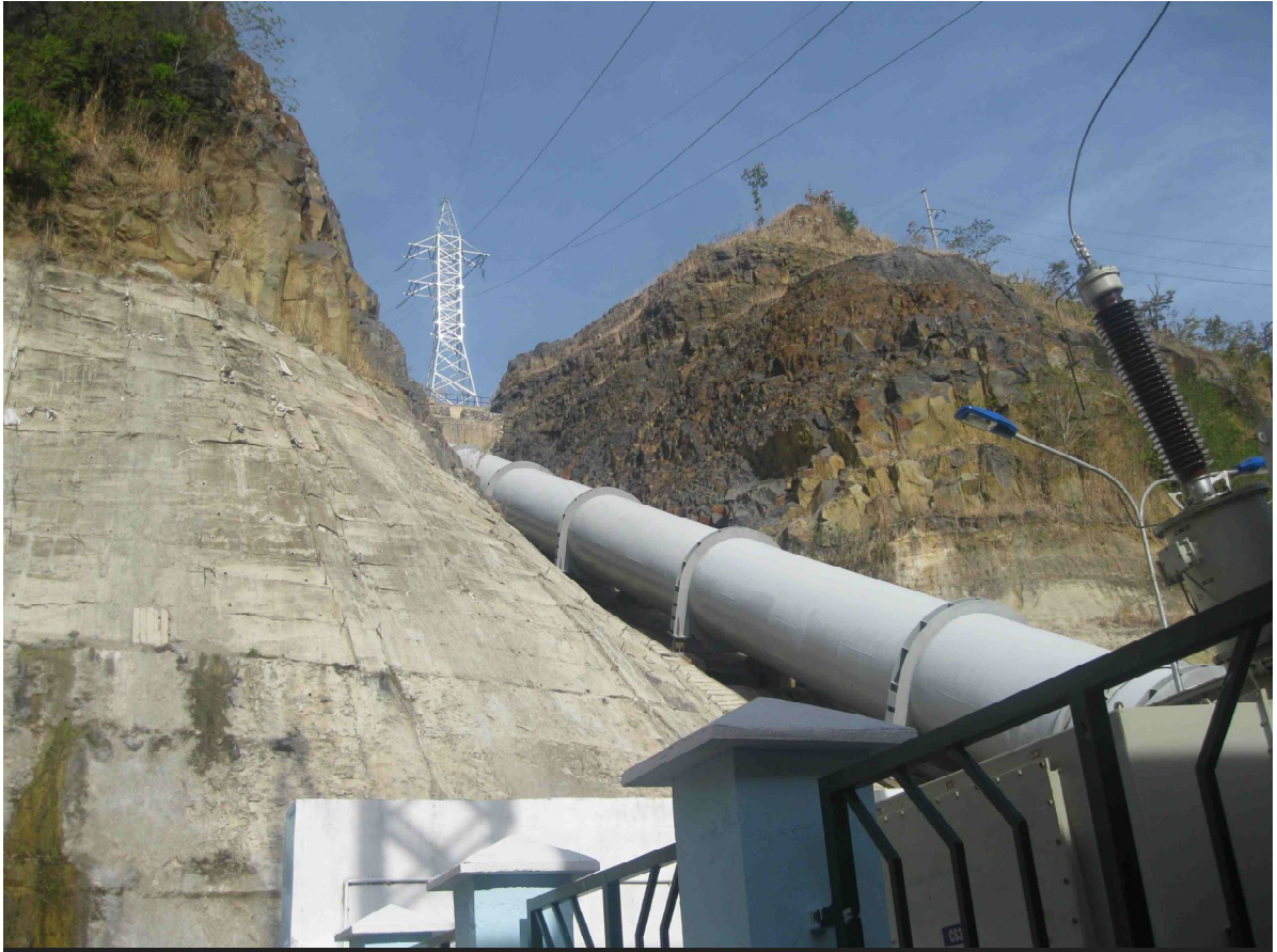
Ảnh: Đường ống áp lực & đường dây cao áp dẫn nối thủy điện H'Mun vào hệ thống điện QG
