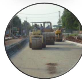
CÔNG TRÌNH ĐƯỜNG BỘ
