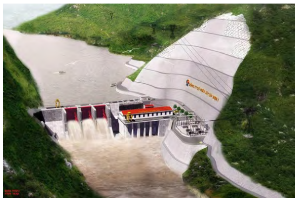
THỦY ĐIỆN BẢO LÂM 3
