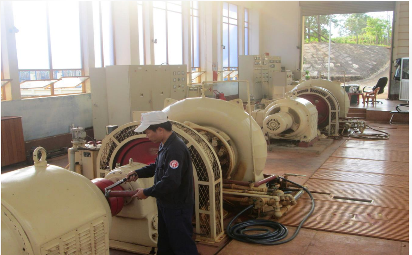
Ảnh: Kiểm tra các thông số máy phát tại nhà máy thủy điện Ia Drăng1
