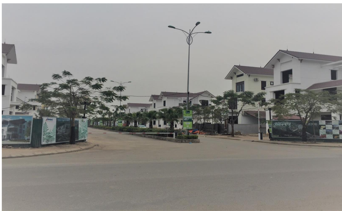
KĐT Phúc Ninh đang trong quá trình xây dựng
