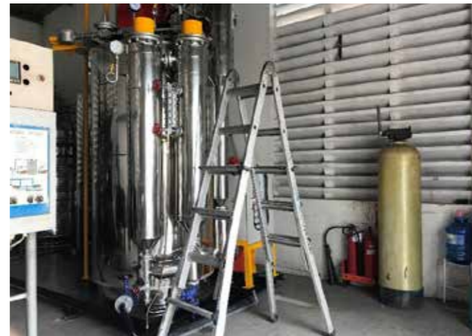
Nhà máy Bibica thay đổi hệ thống lò hơi đốt dầu Diesel sang đốt bằng gas để giảm ô nhiễm
