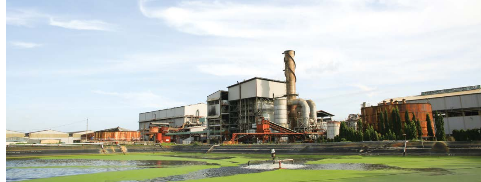
Hồ xử lý nước thải tại Nhà máy TTCS
