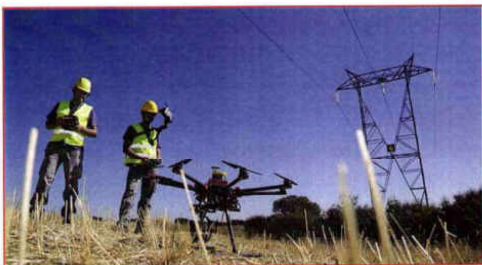
Đào tạo Kỹ thuật kéo dây không chạm đất
