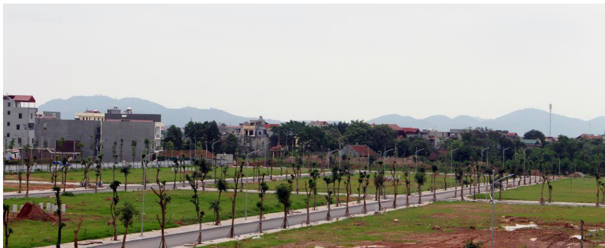
KĐT Phúc Ninh đang hoàn thiện hạ tầng trong tiểu khu 22ha
