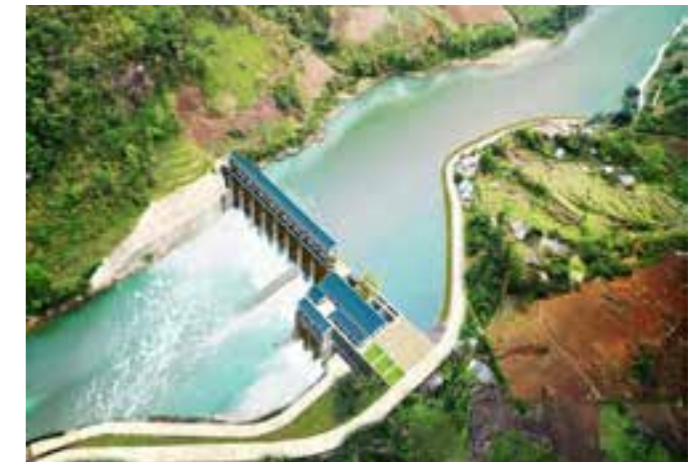
Nhà máy thủy điện Bảo Lâm 3A
