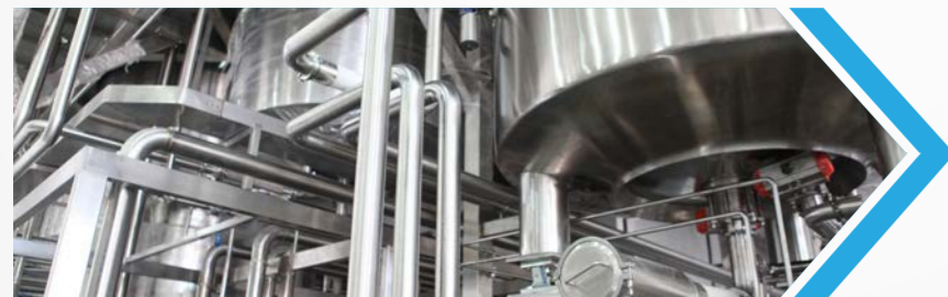
Dự án Nhà máy sản xuất NPK Thủy Nguyên
