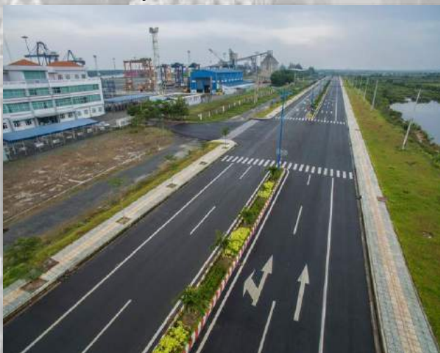
Thi công đường liên cảng Cái Mép – Thị Vải Thị xã Phú Mỹ
