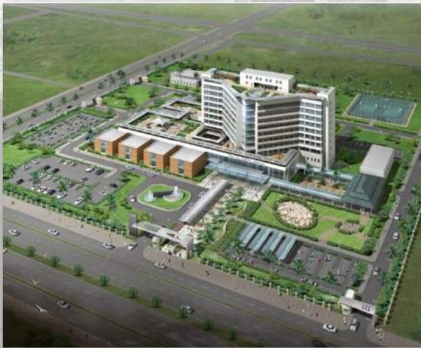
Thi công Bệnh Viện Đa Khoa TP Vũng Tàu tại Thành phố Vũng Tàu
