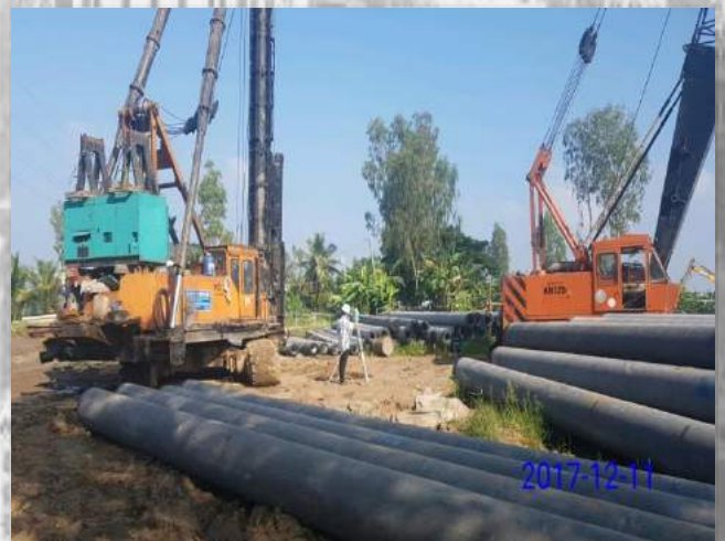
Thi công Cao tốc Lộ Tế - Rạch Sỏi tại Thành phố Cần Thơ
