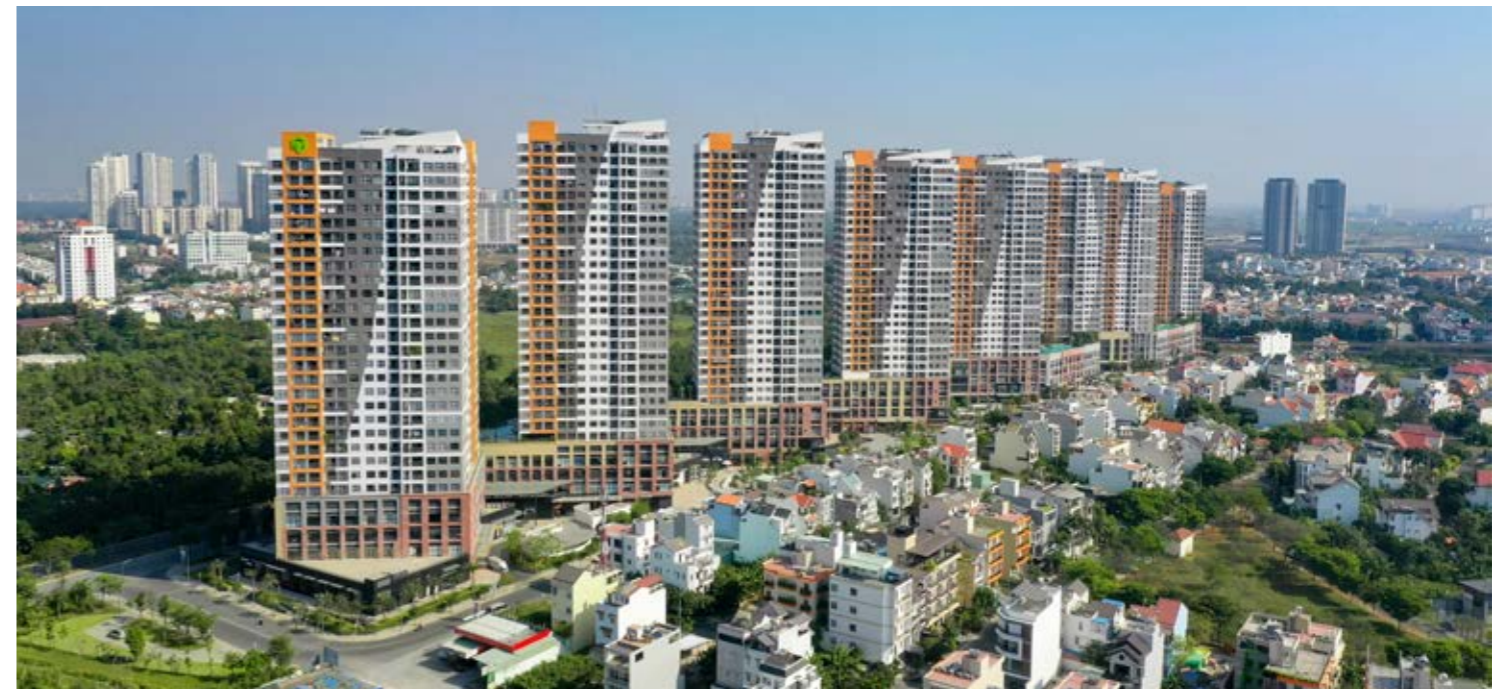
Công trình The Sun Avenue Residence (Q.2. TP.HCM)
