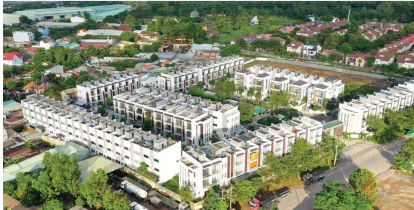
Công trình Golf Park Residence (Q.9, TP.HCM)
