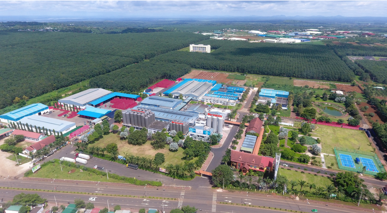
(*) Nhà máy bia Sài Gòn Đắk Lắk công suất 100 triệu lít / năm
