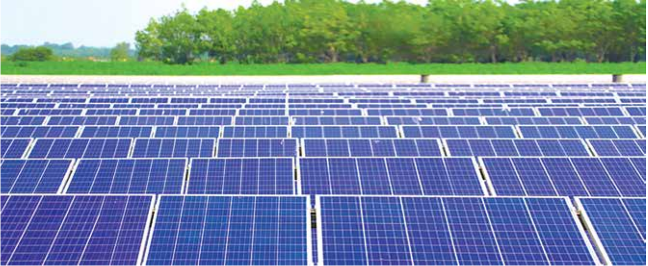
Nhà máy Điện mặt trời Dầu Tiếng 3
