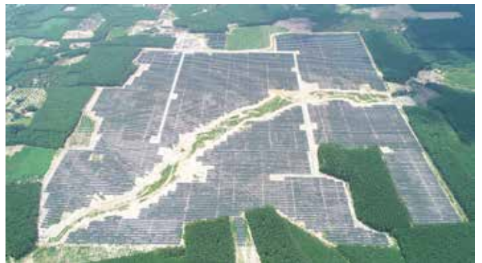
Nhà máy Điện mặt trời Sơn Mỹ 3.1
