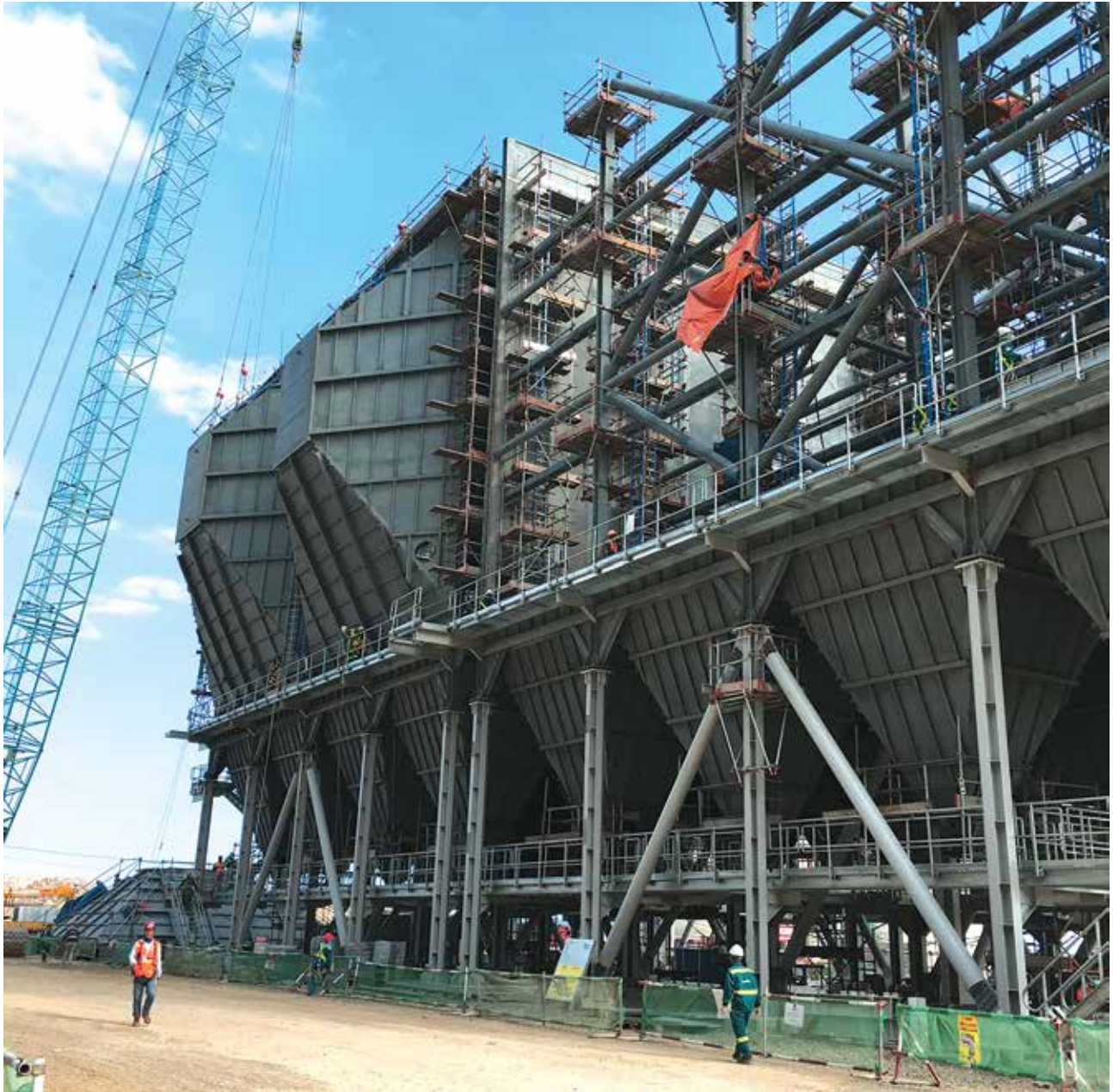
Hệ thống Lọc bụi tĩnh điện
