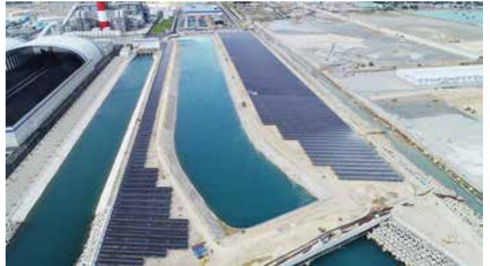
Dự án Nhà máy Điện mặt trời TTĐL Vĩnh Tân
