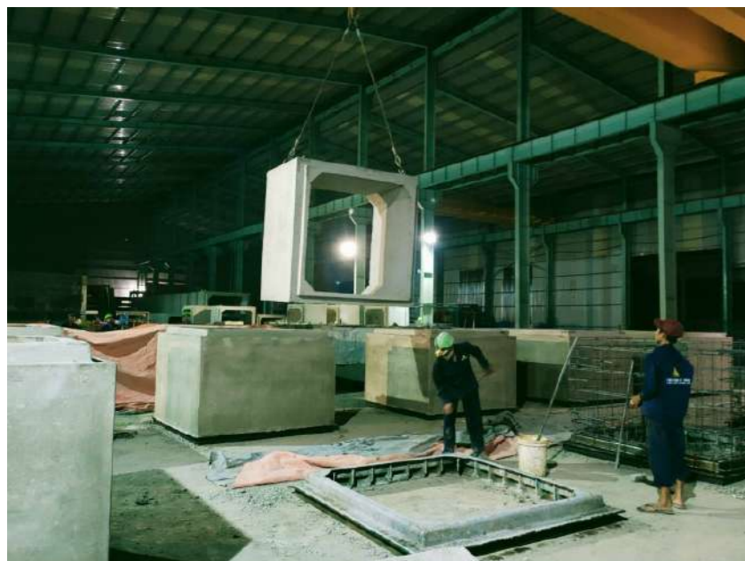
Sản xuất cốt hộp công nghệ rung lõi
