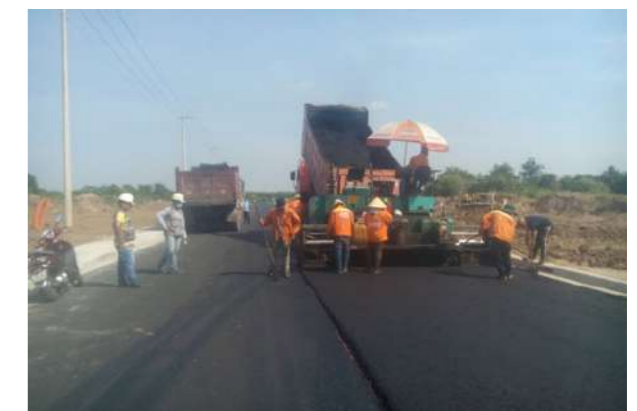
Công trình đường do CIC39 thi công
