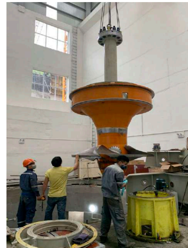
Hạ ROTOR và thả bánh xe Thủy điện Sông Nhiệm 4
