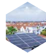
Điện mặt trời áp mái FRESOLAR
