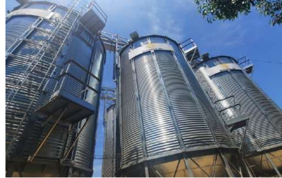
Hệ thống Silo 200m 3 /cái và nghiền trộn thức ăn Organic tự động
