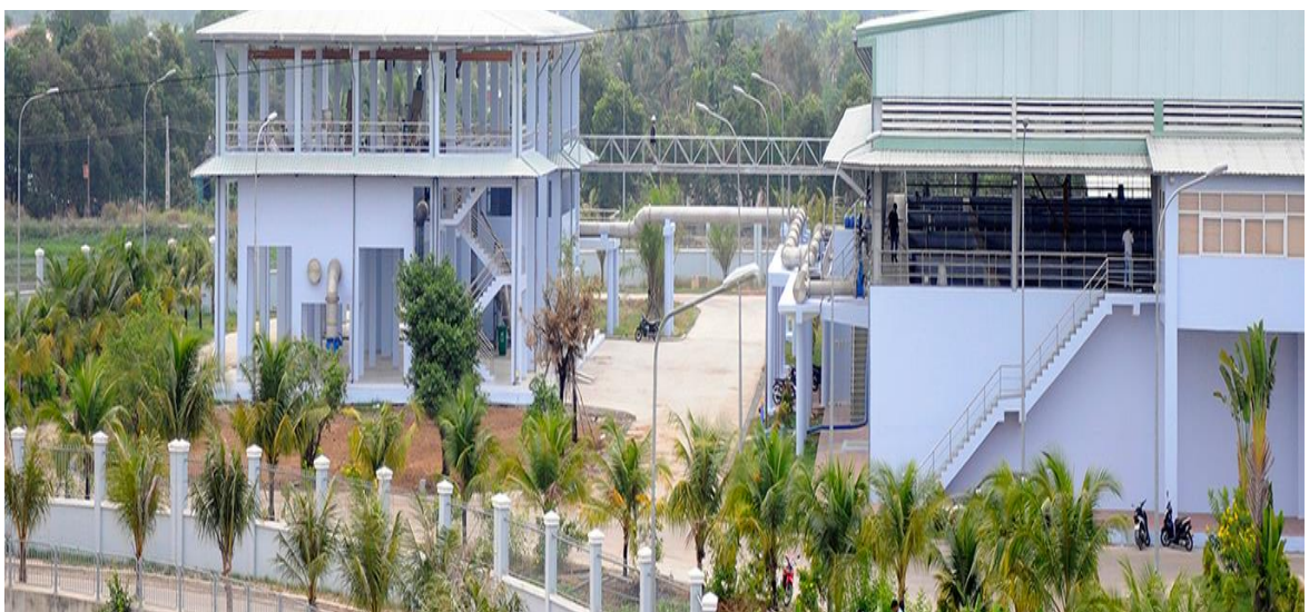
Chi nhánh xử lý nước thải Tân Uyên
