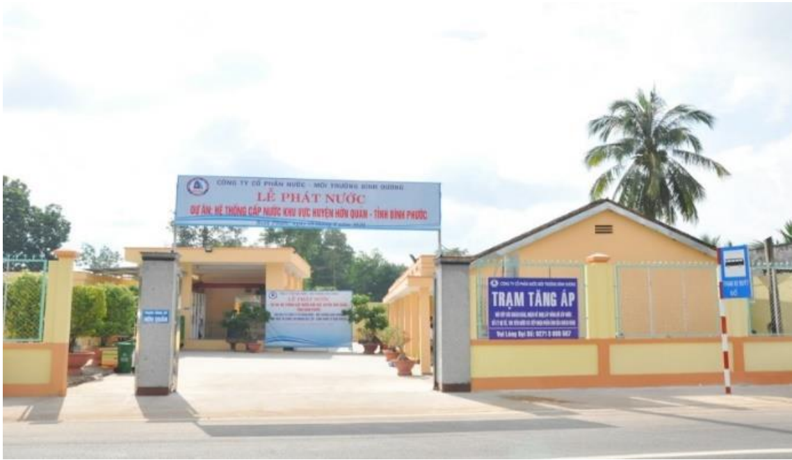
Trạm tăng áp huyện Hón Quán – tỉnh Bình Phước
