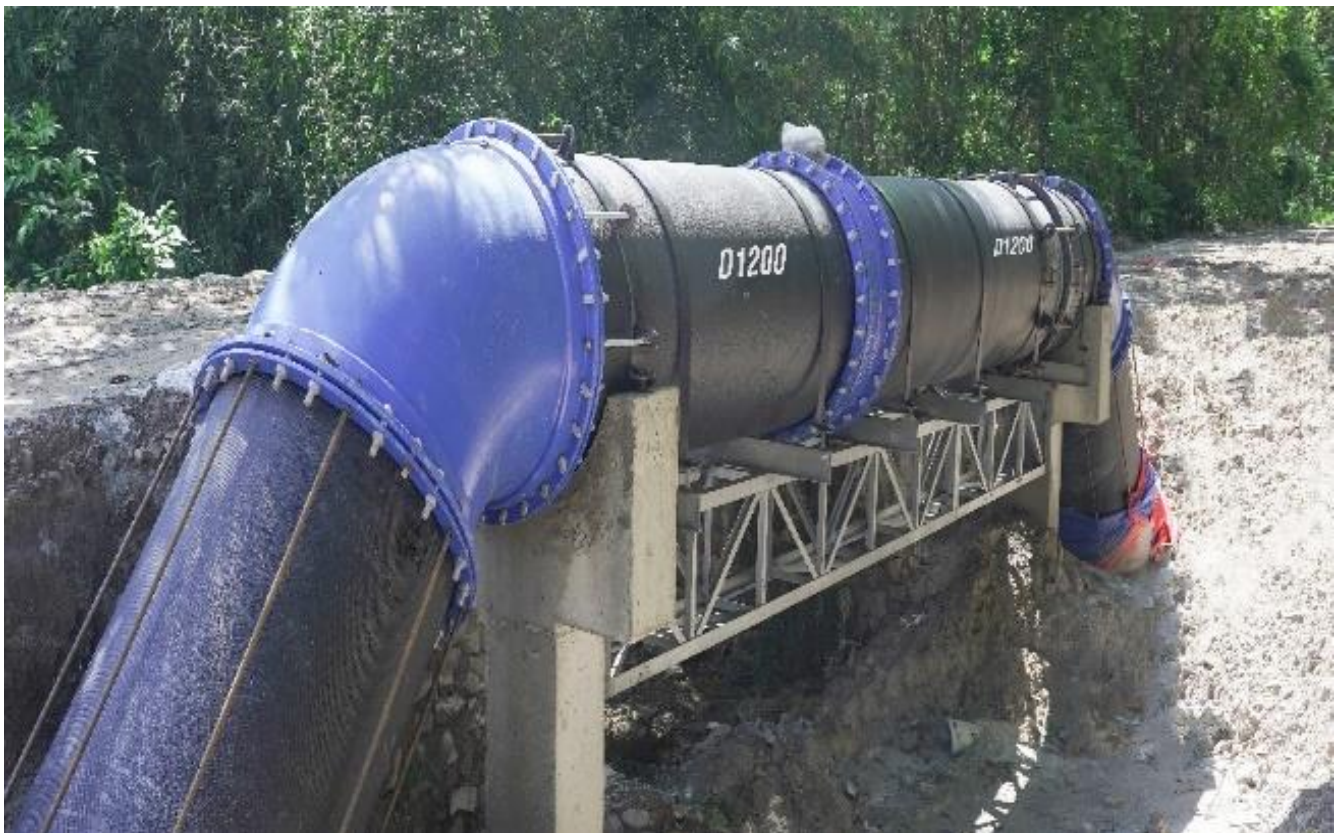
Tuyến ống nước thô D1200mm NMN Chơn Thành
