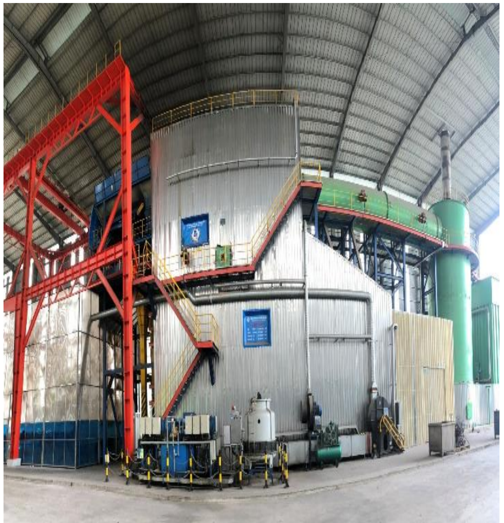
Lò đốt rác 200 tấn/giờ do công ty thiết kế thi công với mục tiêu kép vừa đốt rác công nghiệp, sinh hoạt vừa phát điện
