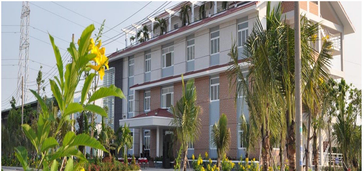
Chi nhánh xử lý nước thải Thuận An
