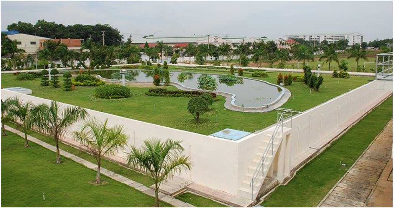
Bể chứa nước sạch 7000m 3 của nhà máy nước Dĩ An
