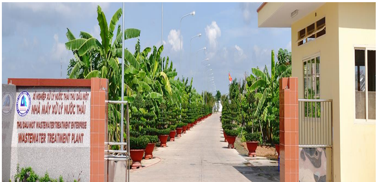
Chi nhánh Xử lý nước thải Thủ Dầu Một
