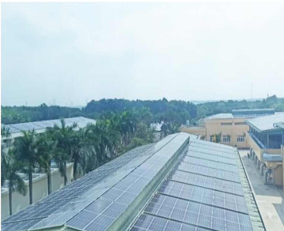
Hệ thống điện mặt trời áp mái, công suất 3MWh
