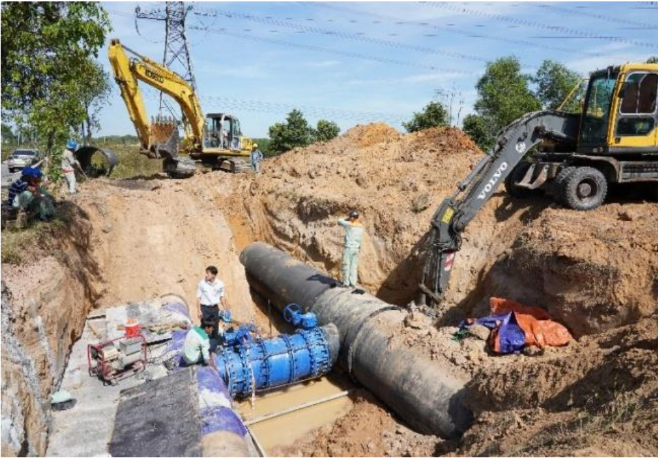
Thi công tuyến ống nước sạch D1500mm cho khu vực Thành phố mới Bình Dương và Tx. Bến Cát
