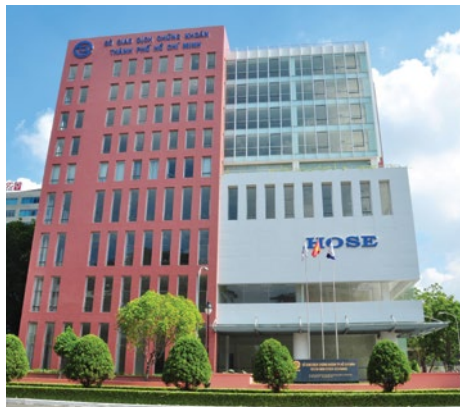
Tòa nhà Trung tâm Dữ liệu dự phòng của HOSE.
