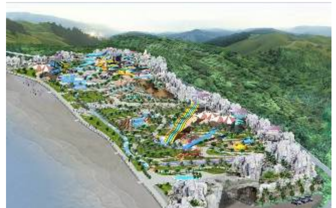
Thi công núi giả đá – Khu du lịch Hòn Tre – Nha Trang
