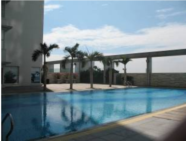
Thi công hồ bơi Tòa nhà Everich đường 3/2
