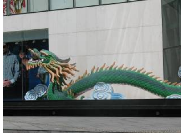
Thi công con Rồng Tòa nhà Everich đường 3/2
