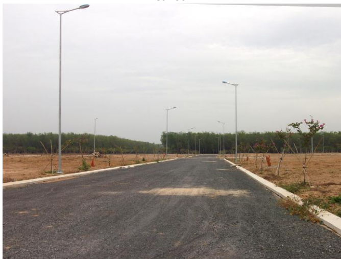
Ảnh một tuyến đường nội bộ trong khu 1D-20 ha đang chuẩn bị thảm nhựa
