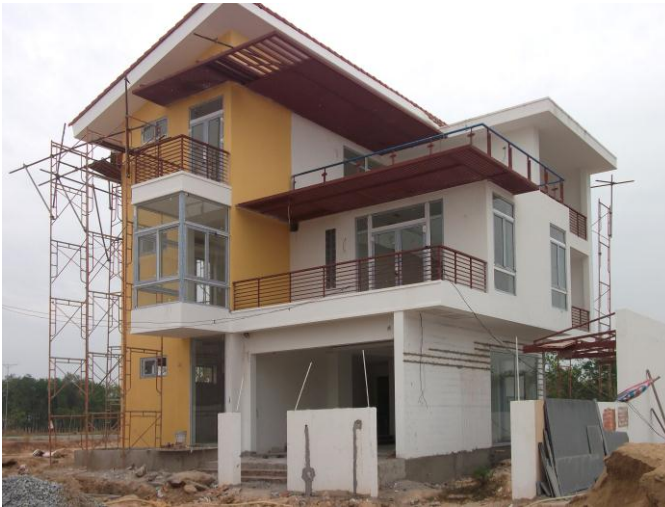
Ảnh nhà mẫu Biệt thự F1 diện tích đất 300m 2 đang giai đoạn hoàn thiện thuộc phân khu 1D-20 ha của khu Đô thị Đông Sài Gòn
