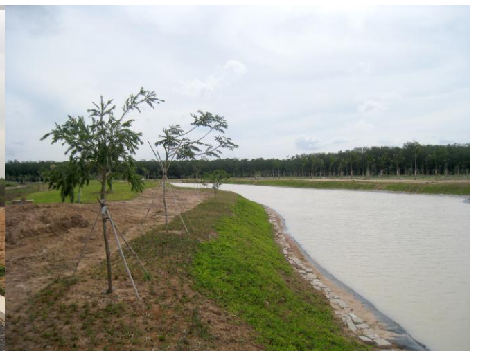
Ảnh kênh nước cảnh quang công viên khu 1D-20 ha đang giai đoạn hoàn thiện
