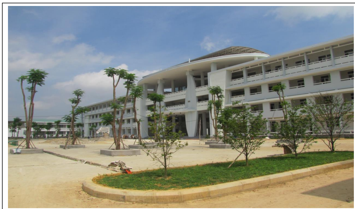
CÔNG TRÌNH TRƯỜNG THCS NGUYỄN TRI PHƯƠNG
