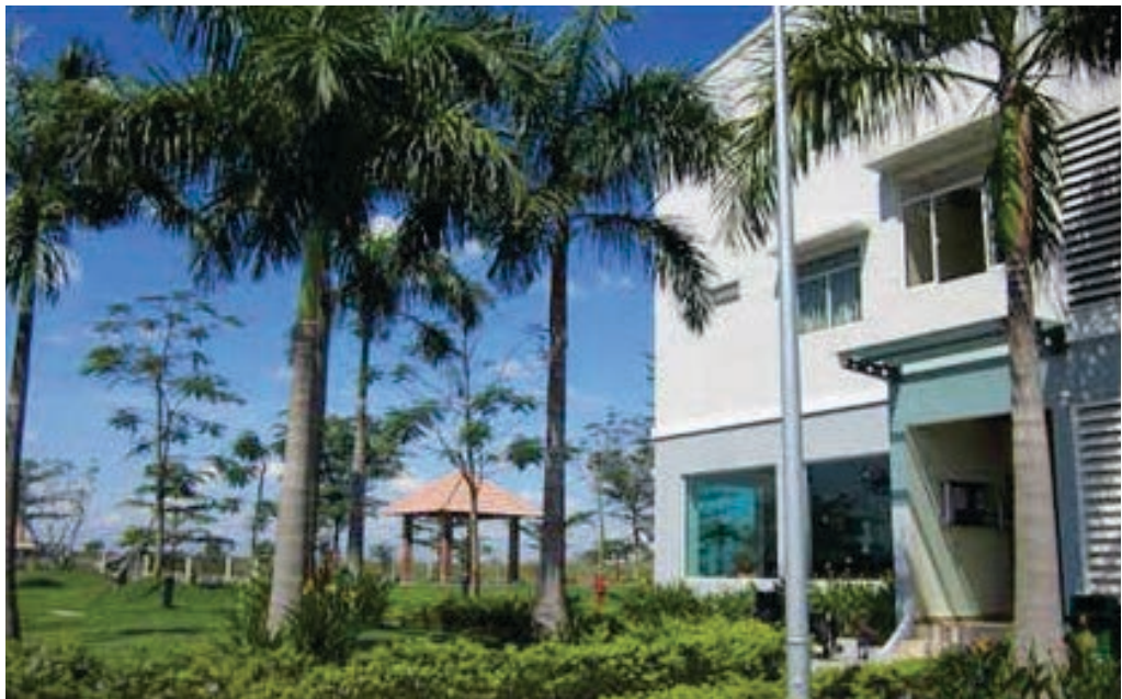
Khu Nhà Ở Dành Cho Đội Ngũ Kỹ Sư Hiện Trường, Công Trình ABI-Bình Dương
