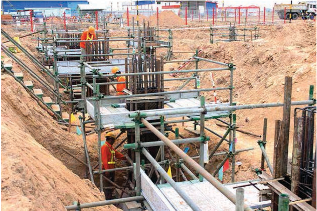
Thực hiện chuỗi hoạt động “1 GIỜ THI CÔNG THỰC TẾ” - huấn luyện đội ngũ cán bộ công nhân viên công ty thực hành các hạng mục thi công của công nhân tại công trường, tối thiểu 1 giờ/tuần.
