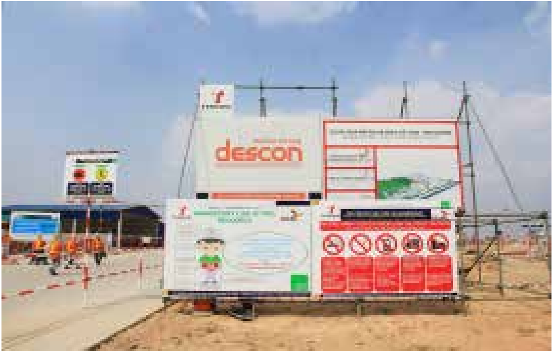
Lối vào công trường
