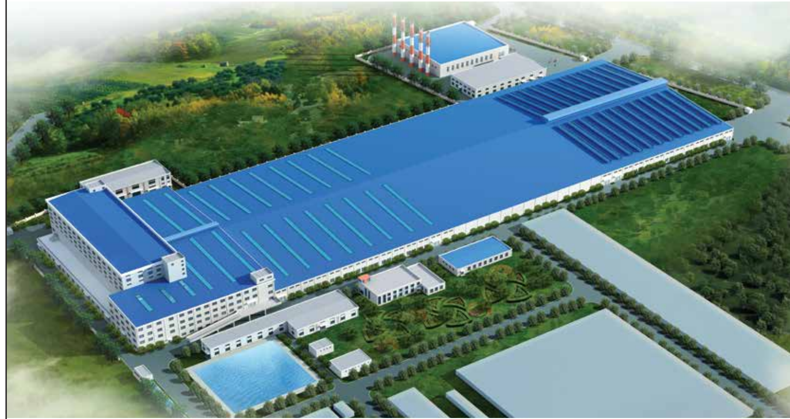
NHÀ XƯỞNG SẢN XUẤT LỐP XE RADIANT
