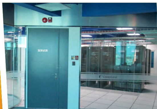
Trung tâm dữ liệu Co-opbank tại Hưng Yên
