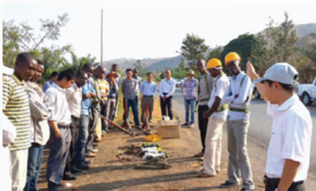
Nhân viên Lumitel đang được hướng dẫn thi công trồng cột.
