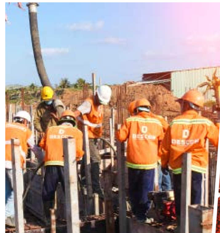
THI CÔNG CÔNG TRÌNH DÀN DỤNG, NHÀ XƯƠNG, HẠ TẦNG
