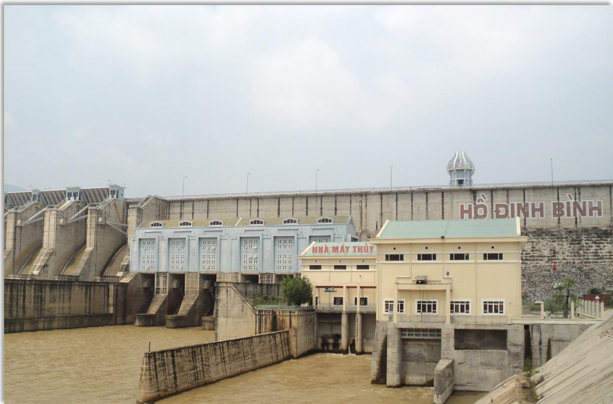
(*) Toàn cảnh Nhà máy Thủy Điện 9,9 MW
