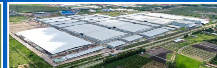
Nhà xưởng Brotex Khu B - Giai đoạn 3
