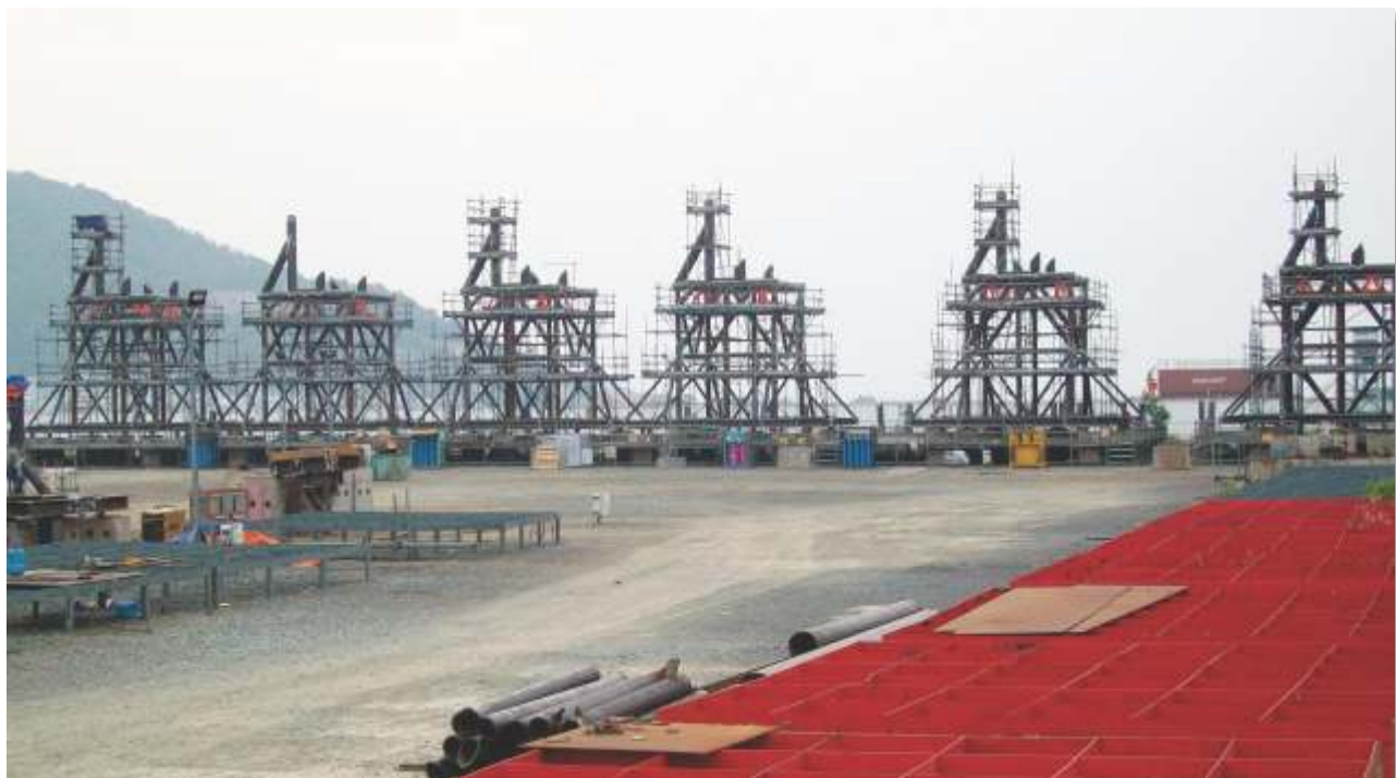
Thi công gói thầu "Fabrication of spools & Spreader transportation & Seafastening" cho Công ty Cổ phần Dịch vụ Lắp đặt, Vận hành và Bảo dưỡng Công trình Dầu khí biển POS
