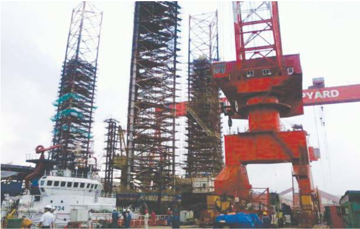
Thi công sửa chữa Giàn khoan Tam Đảo - 01 tại Nhà máy đóng tàu Dung Quất
