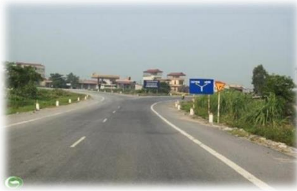
Dự án nâng cấp QL38 đoạn Yên Lệnh – Vực vòng
