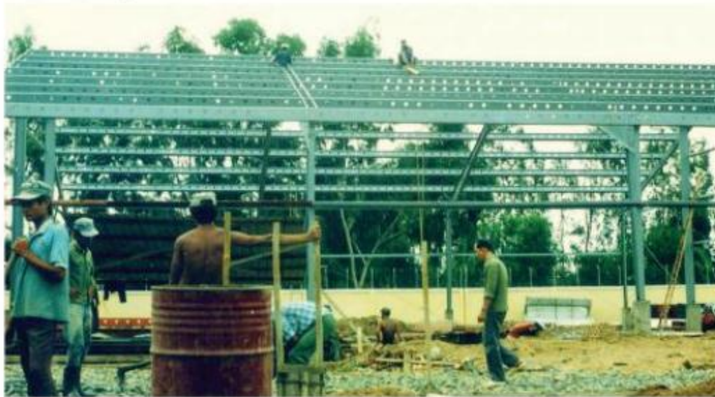
Khởi công xây dựng nhà máy
