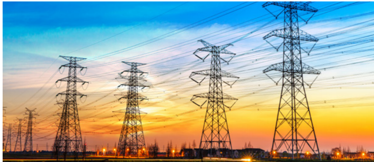
Đường dây truyền tải điện 500kV Bắc Nam
