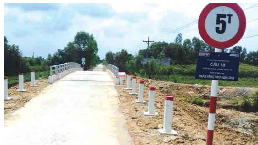
Cầu Kênh 1B tại huyện Thanh Hóa, tỉnh Long An do Kienlongbank tài trợ xây dựng
