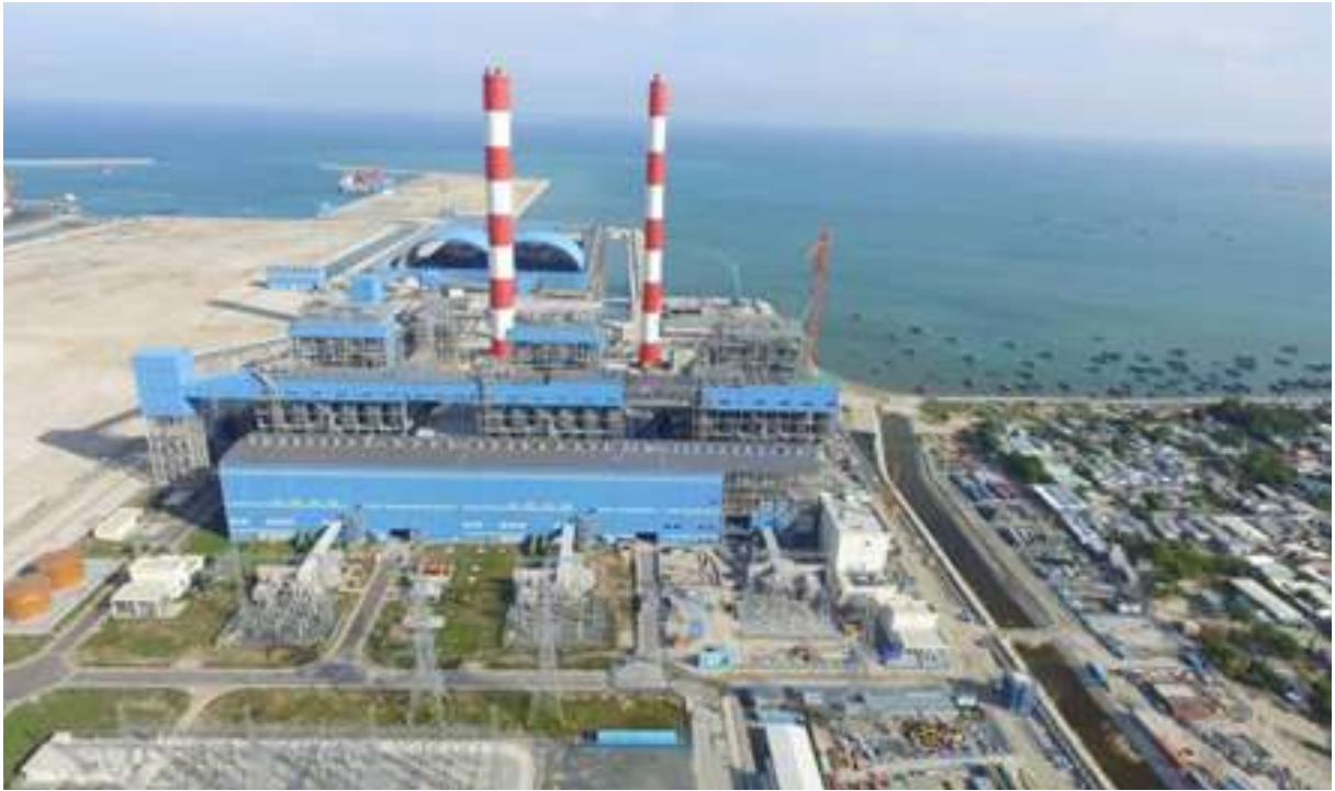
Dự án Nhiệt điện Vinh Tân 4 và Vinh Tân 4 Mở rộng
