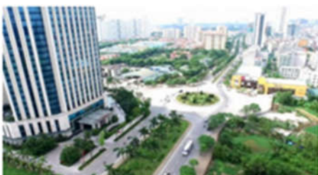
DỰ ÁN XÂY DỰNG TUYẾN ĐƯỜNG TỪ ĐƯỜNG LÊ ĐỨC THỌ ĐẾN ĐƯỜNG 70 (HỢP ĐỒNG BT)
