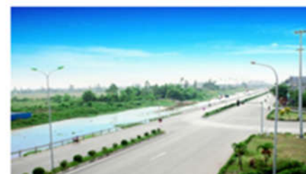
DỰ ÁN CẢI TẠO, NÂNG CẤP QUỐC LỘ 10 ĐOẠN QUA TỈNH THÁI BÌNH (HỢP ĐỒNG BOT)
