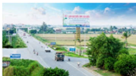
DỰ ÁN XÂY DỰNG CÔNG TRÌNH NÂNG CẤP ĐƯỜNG TỈNH 39B THÁI BÌNH (HỢP ĐỒNG BT)
