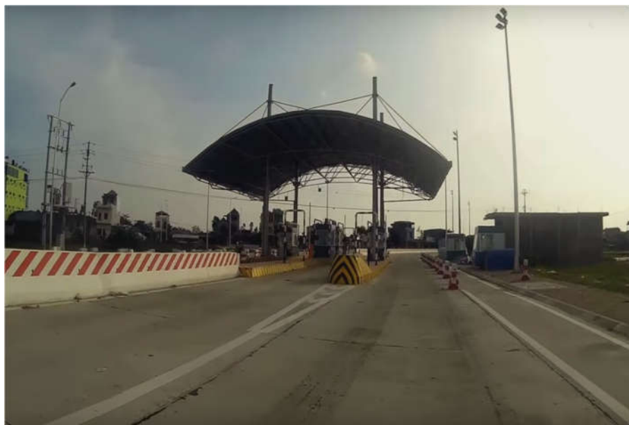
Dự án BOT 39 (Thanh Nê, Diêm Điền, Thái Bình)
