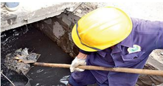
Duy tu đường, mương, cống thoát nước
