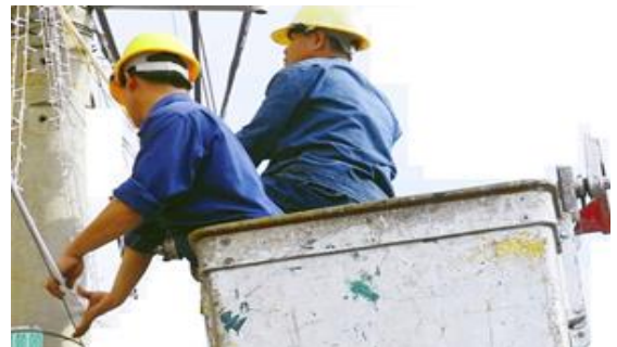
Thi công, duy tu, sửa chữa hệ thống điện chiếu sáng
