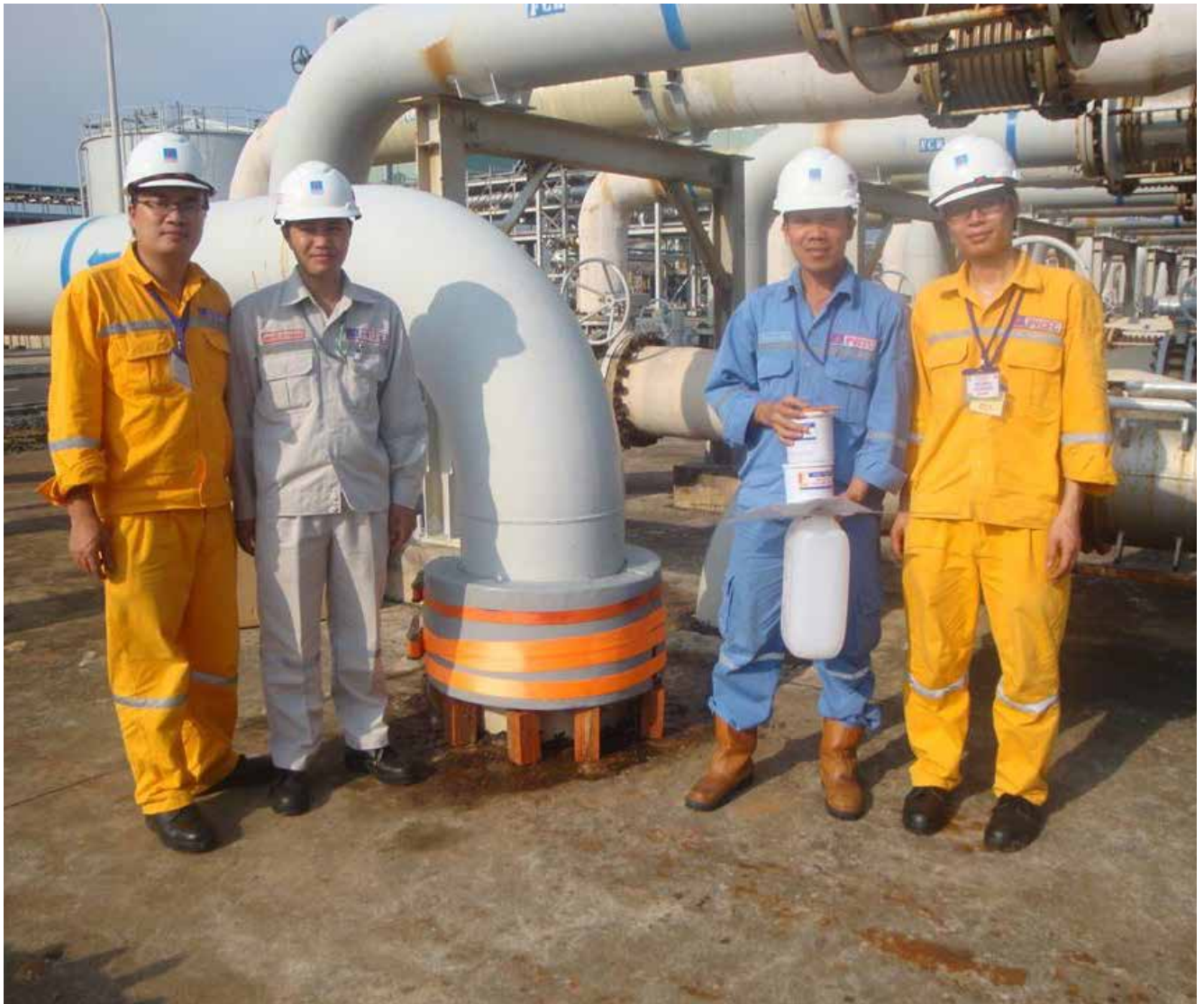
Kỹ sư DMC thực hiện xử lý chống ăn mòn tại Nhà máy Đạm Phú Mỹ
