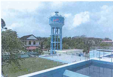
Nâng cấp tạm thời NMN Tứ Hạ (T01)
