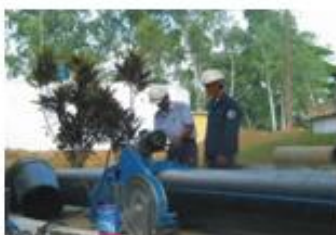
Vận hành máy dán ống DN560
