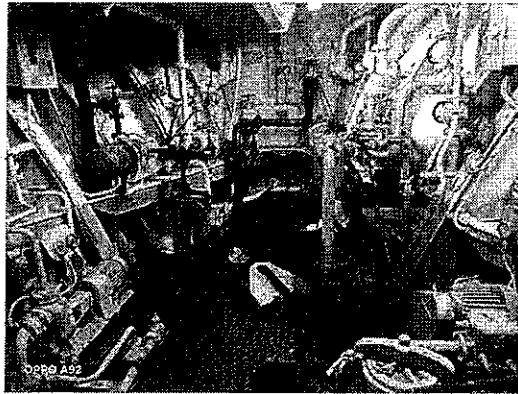
PHOTO 41 HỆ THỐNG BƠM BÀ ĐƯỜNG ỐNG KHU VỰC TRỤC LAB
