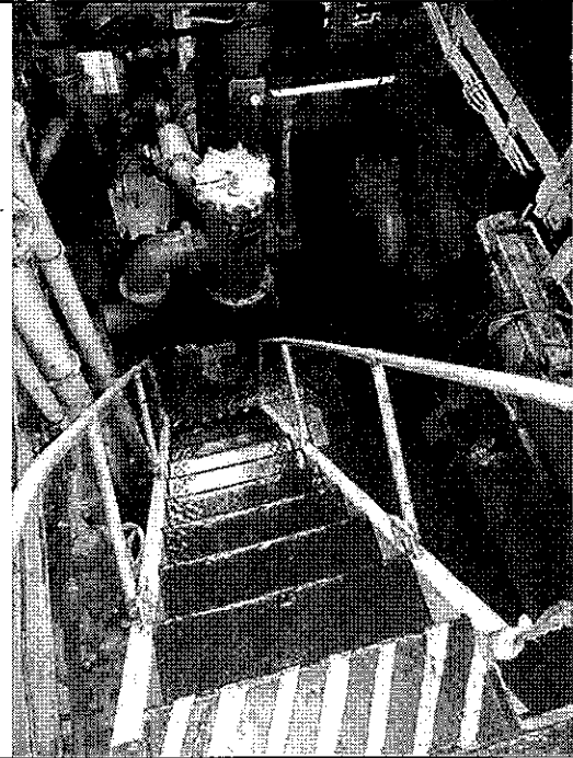
PHOTO 34 CẦU THANG VÀ CÁC BƠM TRONG BUỒNG MÁY
