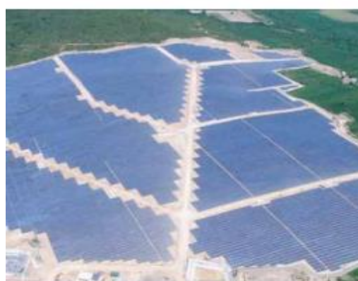
Nhà máy điện mặt trời Krong Pa
