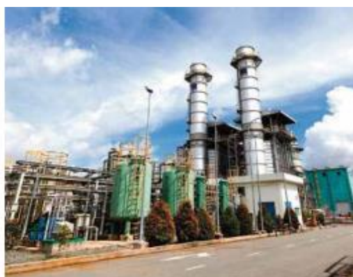
Nhà máy Nhiệt điện Nhơn Trạch 1
