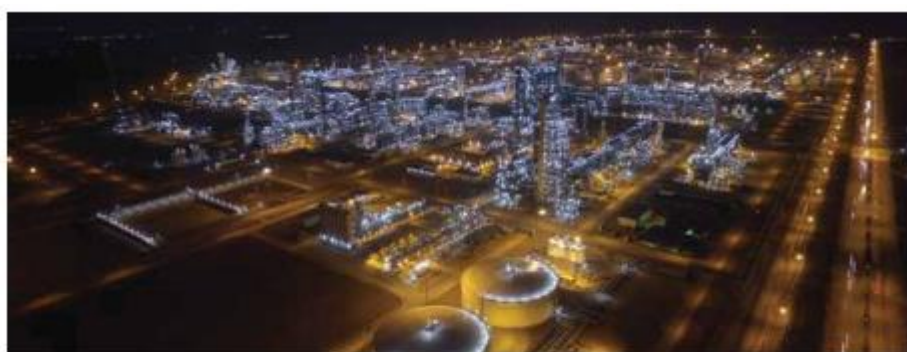
Tổ hợp Lọc hóa dầu Nghi Sơn Địa điểm: tỉnh Thanh Hóa
