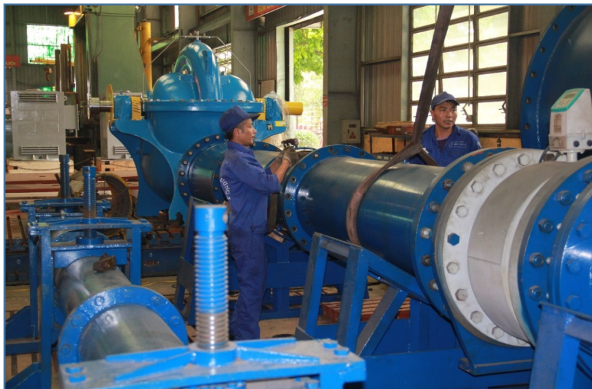
Ảnh: Công nhân Xưởng Lắp ráp – Cơ điện
