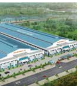
Nhà máy nhuộm Yên Mỹ Vinatex (Hưng Yên)
