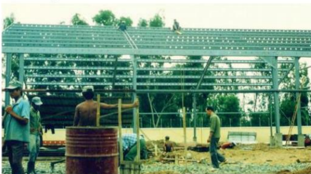
Khởi công xây dựng nhà máy
