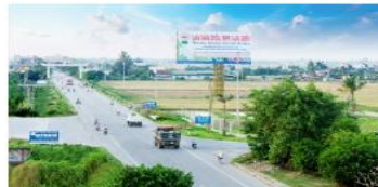
DỰ ÁN XÂY DỰNG CÔNG TRÌNH NANG CẤP ĐƯỜNG TỈNH 39B THÁI BÌNH (HỢP ĐỒNG BT)
