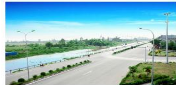
DỰ ÁN CẢI TẠO, NANG CẤP QUỐC LỘ 10 ĐOẠN QUA TỈNH THÁI BÌNH (HỢP ĐỒNG BOT)
