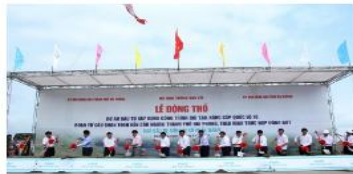
DỰ ÁN CẢI TẠO, NANG CẤP QUỐC LỘ 10 ĐOẠN QUA TP. HẢI PHÒNG (HỢP ĐỒNG BOT)
