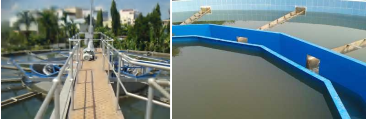
Hình 2: Cụm xử lý nước của Công ty Cổ phần Cấp thoát nước Cần Thơ
