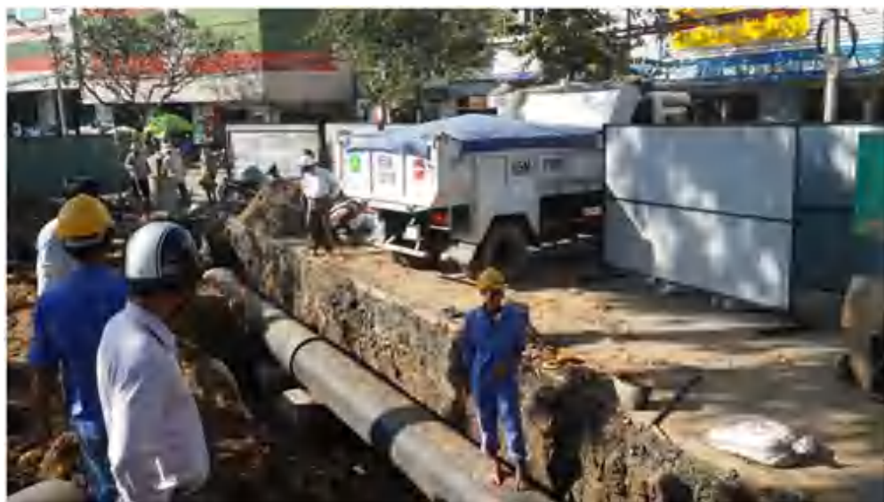
Hình 3: Hình ảnh thi công của Công ty Cổ phần Cấp thoát nước Cần Thơ
